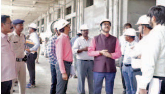
తిరుపతి రైల్వే స్టేషన్ ఆధునీకరణ పనులను తనిఖీలు చేస్తున్న జిఎం జైన్
